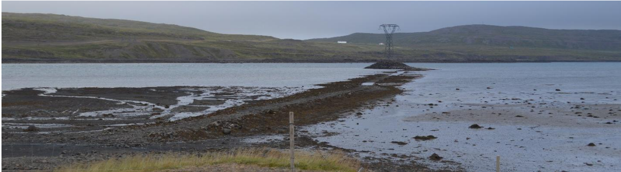
Mynd 25. Rafmagnslína sem liggur yfir Þorskafjörð. Tekið í suðaustur, í átt að Kinnarstöðum. Sama útsýnisstaður og á Þrívíddarmynd 10. Mynd: NAVE/HBA.
